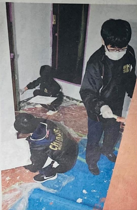
空き家の改修作業に汗を流す千種高校の生徒ら＝兵庫県千種町千草
