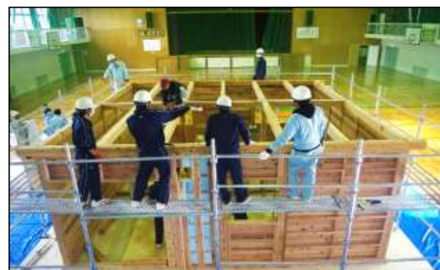
木造仮設住宅(約9坪)
